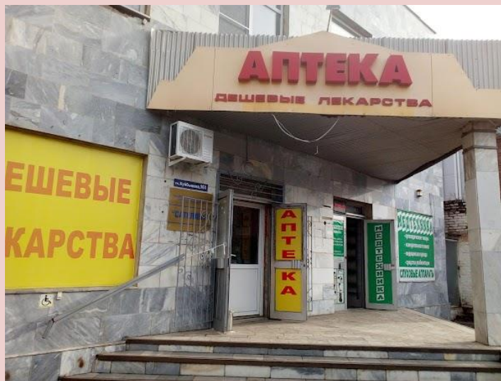
В 2022 году здание не функционирует, на 1 этаже находится аптека
